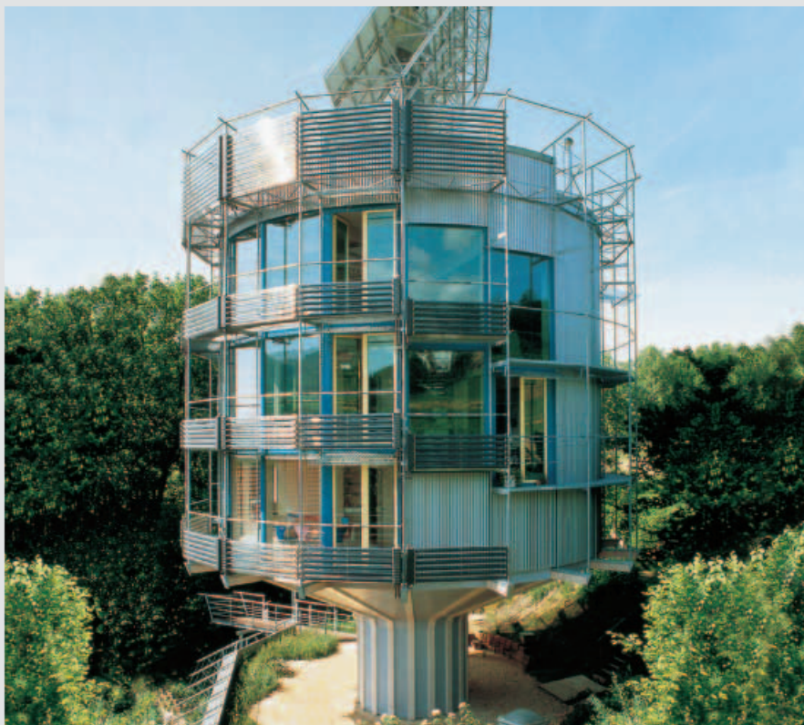
Fig. 43: Heliotrop, Freiburg, capteurs à tubes sous vide
