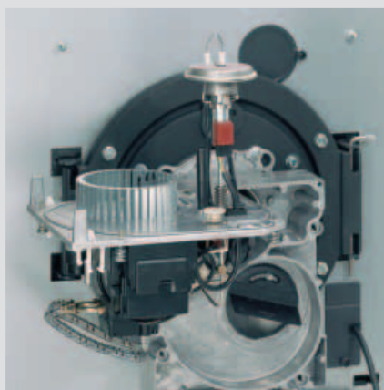
Figure 25: Vitoflame 300 en position d'entretien
