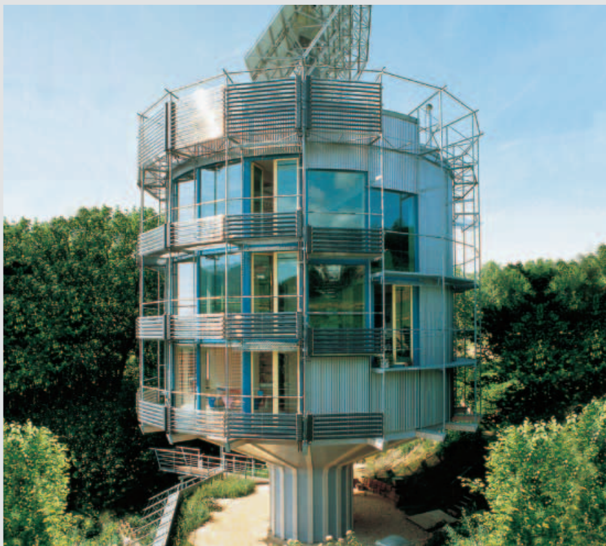
Afb. 43: Heliotrop (in Freiburg, Duitsland) met vacuümbuiscollectoren
