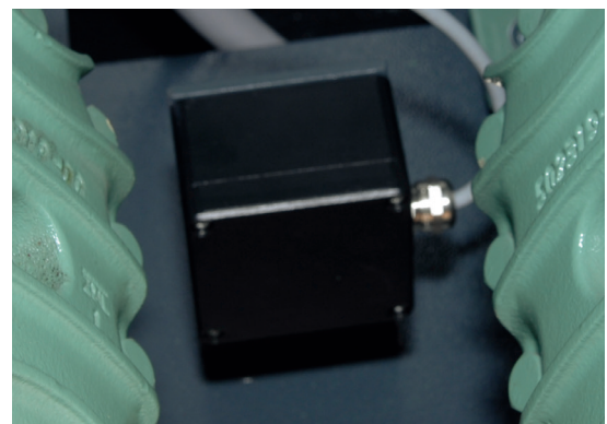
Automatische Dichtigkeitsüberwachung Gasdetektor
