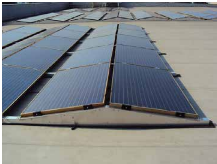
Système d'installation Aero 3.0 pour le Vitovolt 300
