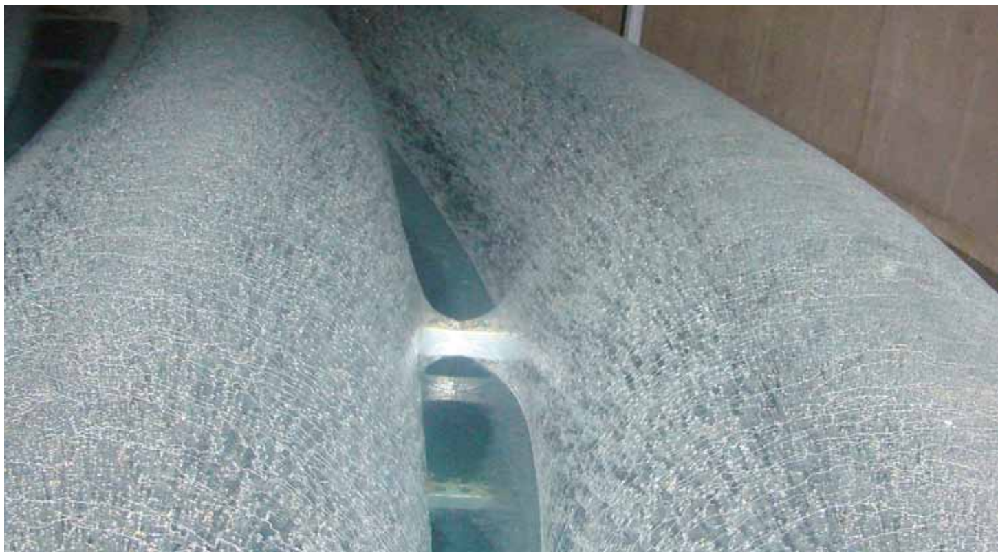
Formation de glace autour de l'échangeur de chaleur dans le réservoir de glace
