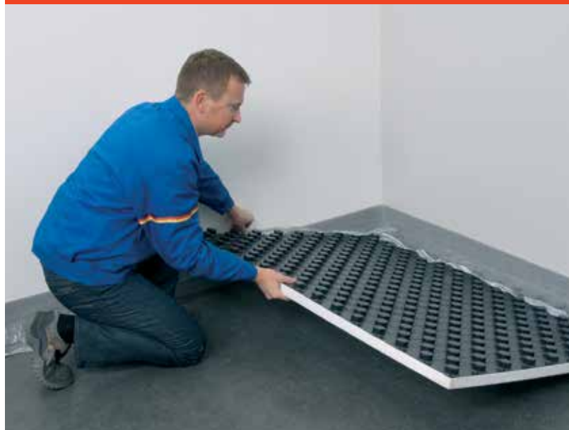
Fig. 4 : Pose de la plaque à plots
