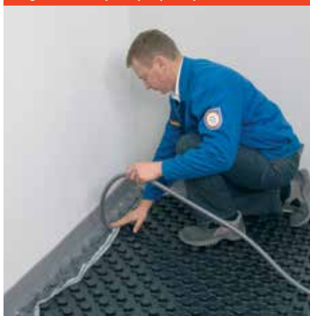
Fig. 8 : Pose du profil périphérique PE
