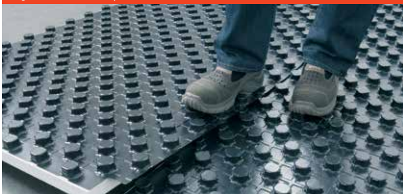
Fig. 7 : Enfoncement des plots
