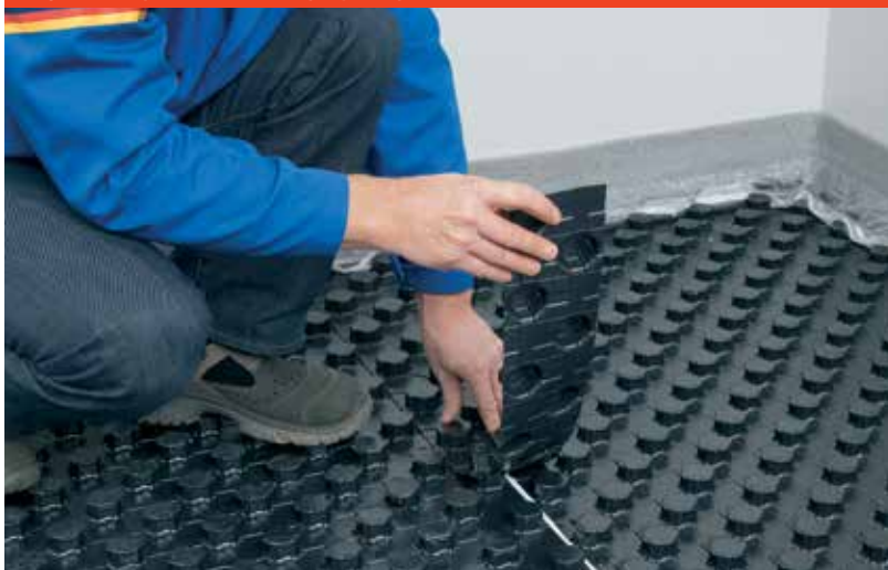
Fig. 6 : Découpe sur mesure des plaques à plots
