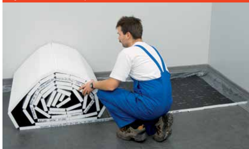
Fig. 15 : Pose du matériau composite
