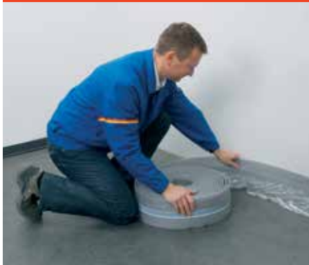
Fig. 2 : Pose de l'isolation périphérique
