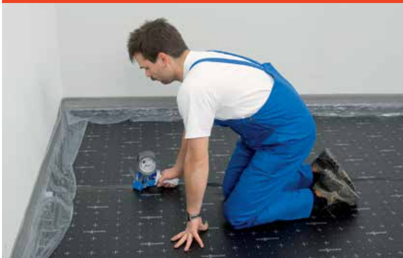
Fig. 16 : Coller les bords de jonction avec du ruban adhésif
