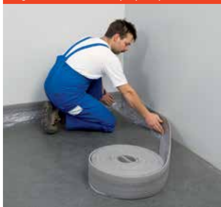
Fig. 14 : Pose de l'isolation périphérique
