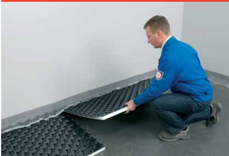
Fig. 5 : Pose de plaques contiguës
