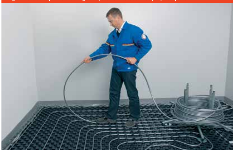
Fig. 9 : Pose du tuyau de chauffage du système Vitoset sur les plaques à plots
