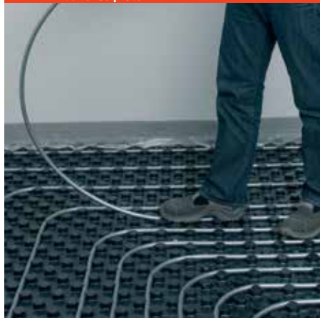
Fig. 10: Enfoncer le tuyau de chauffage du système dans les plots
