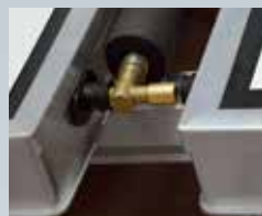
Tweede collector in de aansluitingen schuiven
