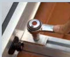
Eerste collector plaatsen en bevestigen
