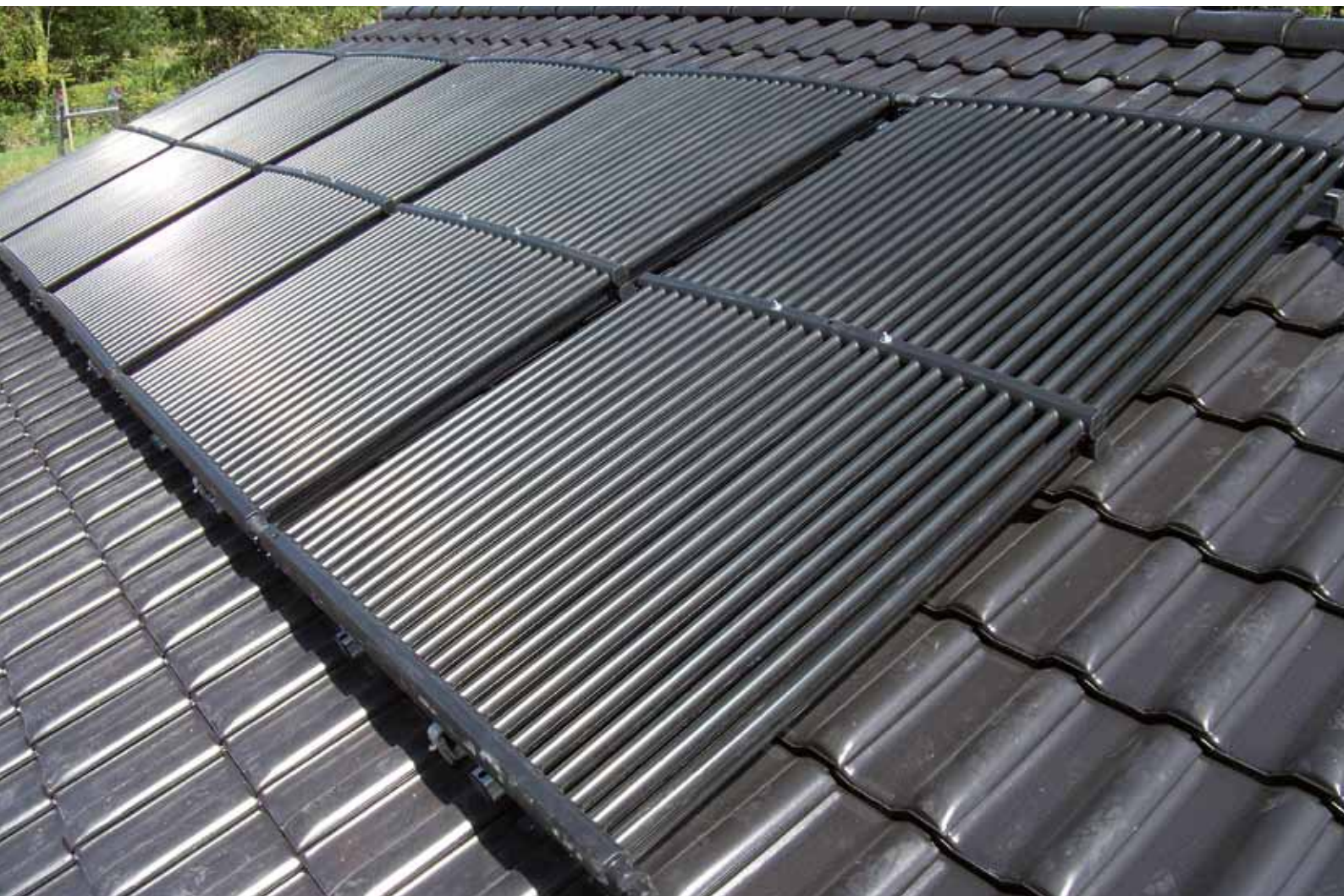
zonne-/luchtabsorbers voor installaties met een Viessmann ijsreservoir en een warmtepomp
