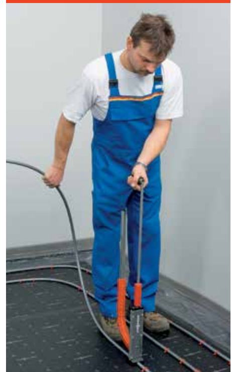
Fig. 17: Buizen fixeren met buishouders
