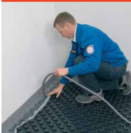
Fig. 8: Rond PE-profiel plaatsen
