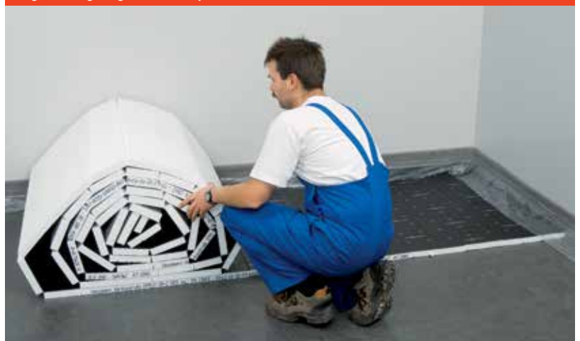
Fig. 15: Het gelaagde materiaal plaatsen
