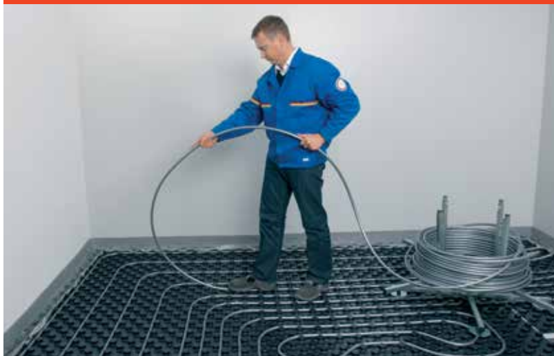
Fig. 9: Vitaset-systeemverwarmingsbuis op de noppen-elementen plaatsen
