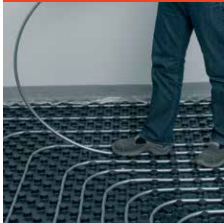
Fig. 10: De systeemverwarmingsbuis in de noppen drukken
