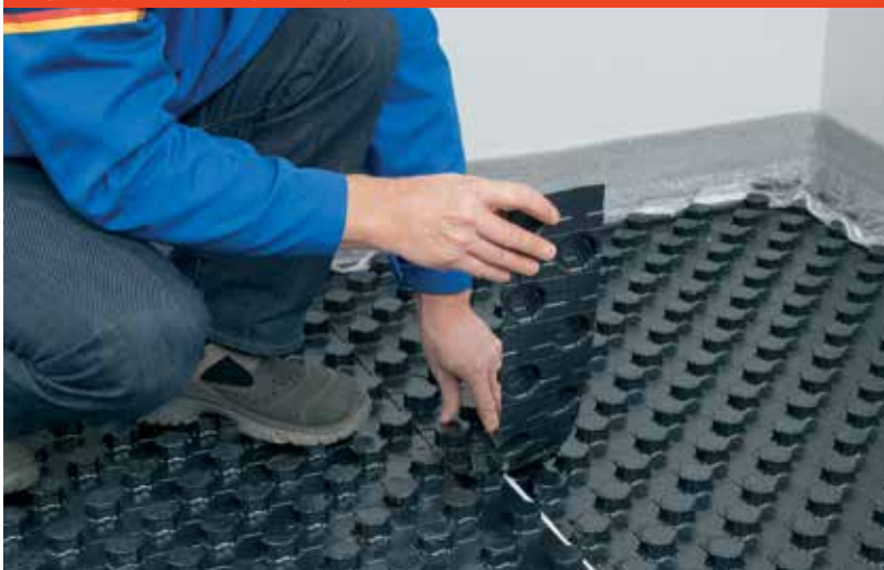
Fig. 6: Noppen-element op maat snijden
