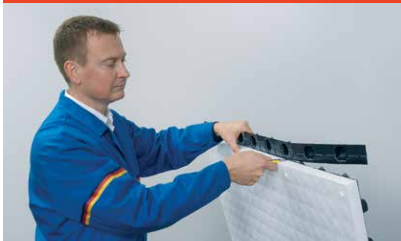
Fig. 3: De uitstekende folie afsnijden van het noppen-element
